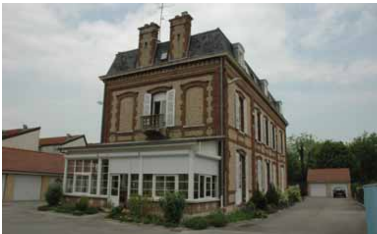
Das Haus der Frau Boursetty, das Louis Brisson zu einem Waisenhaus umbaute
