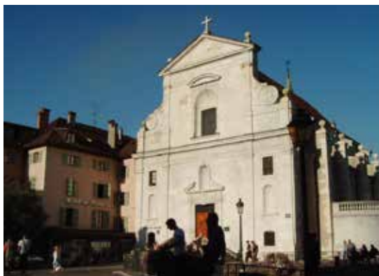
Die Kirche St. François de Sales, links ist das ehemalige Heimsuchungskloster, heute „Hotel de Savoie“
